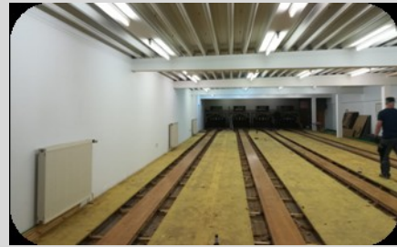
Abriss hat begonnen
